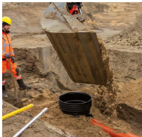
Малюнок 49: Монтаж трубопроводу PVC
