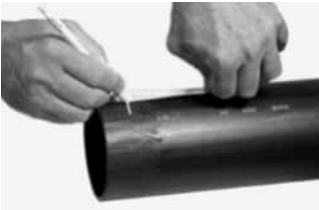
Для ремонтної муфти зона шліфування має продовжуватись на всю її довжину
