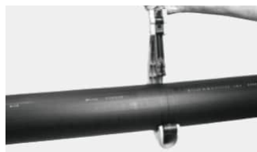
Відрізання труби роликівим труборізом
