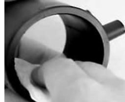
Очищення й знежирення внутрішньої поверхні електромуфти
