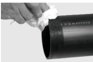
Очищення й знежирення відшліфованої зони на трубі
