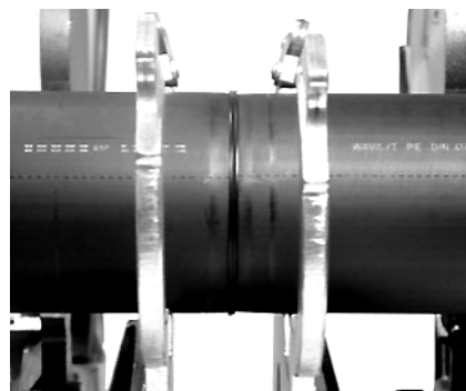
Готове стикове з'єднання труб HDPE
