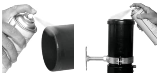
Нанесення силіконового змащувача
