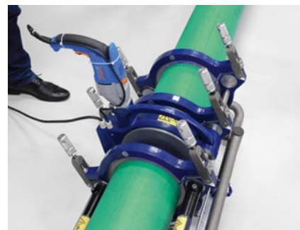
Вирівнювання кінців трубопроводу торцювальним пристроєм
