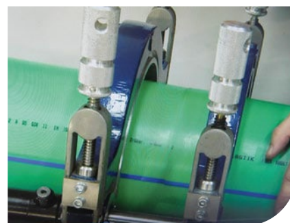
Контроль зміщення трубопроводу перед зварюванням
