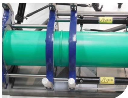
Зварювання й охолодження шва
