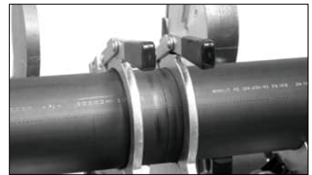
Трубопровід готовий до зварювання
