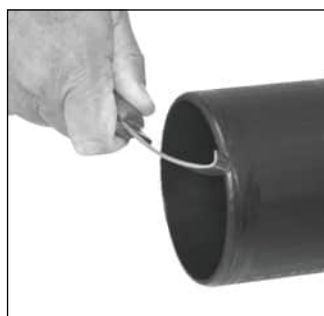
Скошування кромки труби
