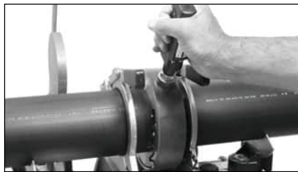
Торцювання кінців трубопроводу
